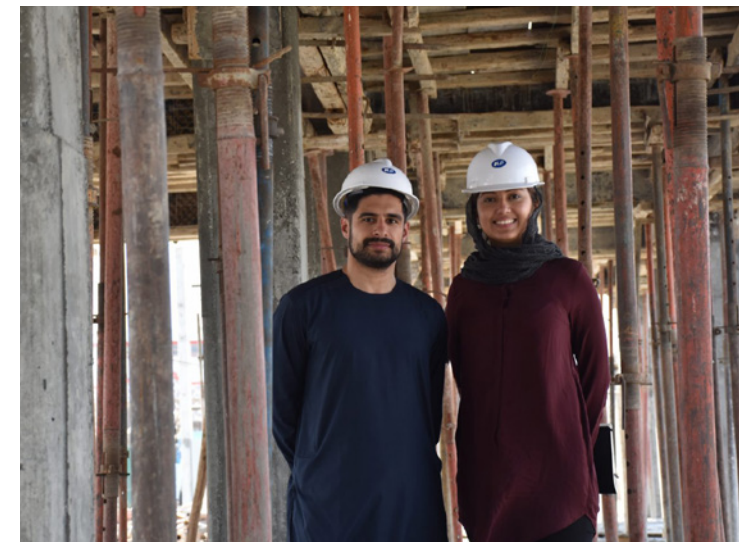
Arthur und Hila im März 2019 auf der Baustelle der Khwaja Boghra Grund- und Mittelschule in Kabul
