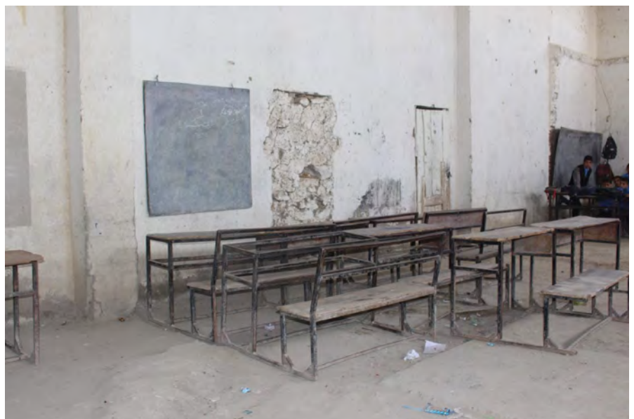
altes Schulgebäude der Projektschule Khwaja Boghra
