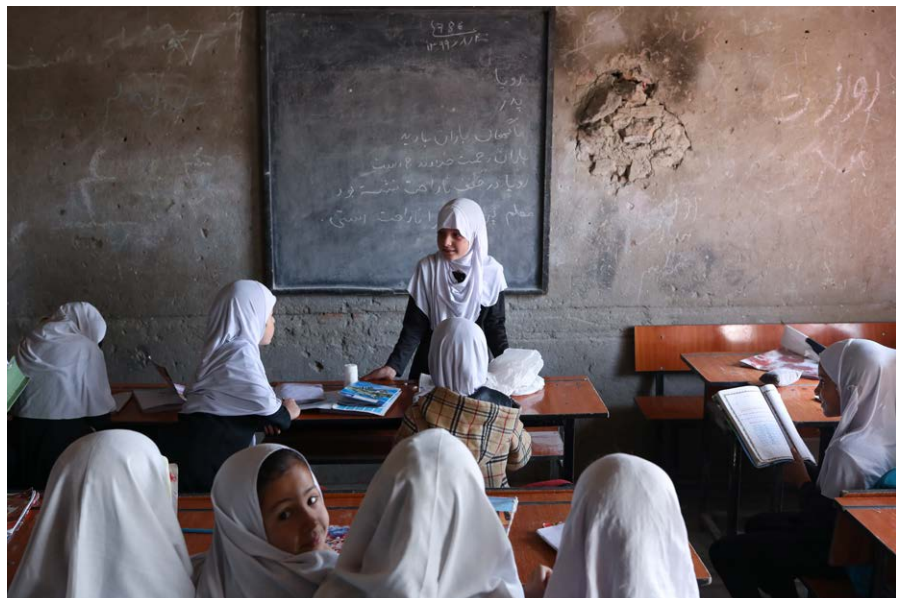
Alter Klassenraum der Projektschule Khwaja Boghra
