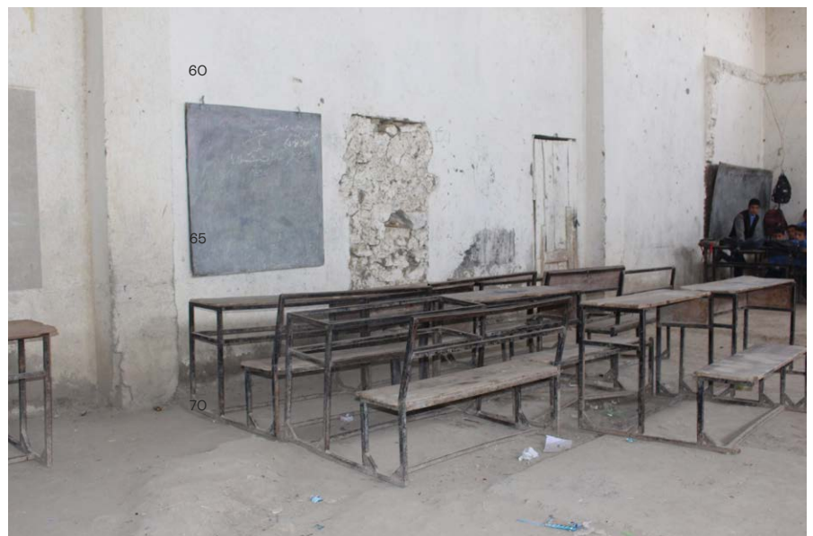
Altes Schulgebäude der Projektschule Khwaja Boghra
