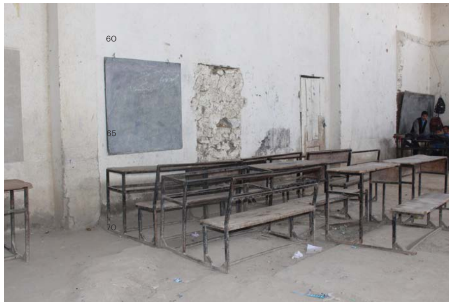
altes Schulgebäude der Projektschule Khwaja Boghra
